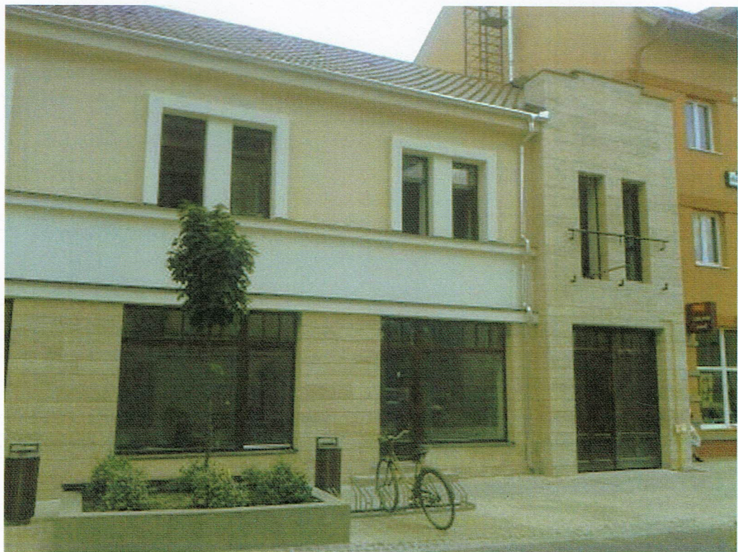
Monor, Posta épület homlokzat, Jura mészkő, ragasztott technológiával
