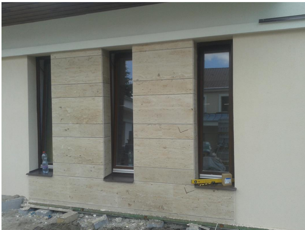
(hátsó melléképület burkolás utáni udvari homlokzat)
