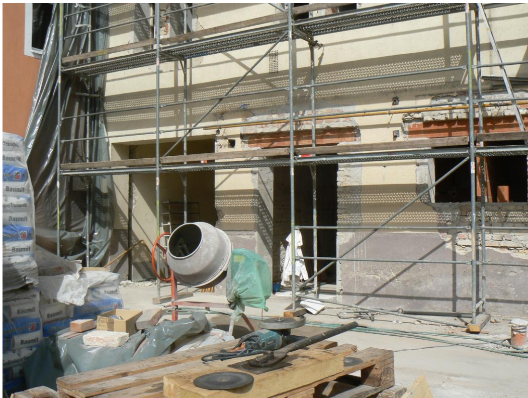
(főépület burkolás előtti udvari homlokzat)
