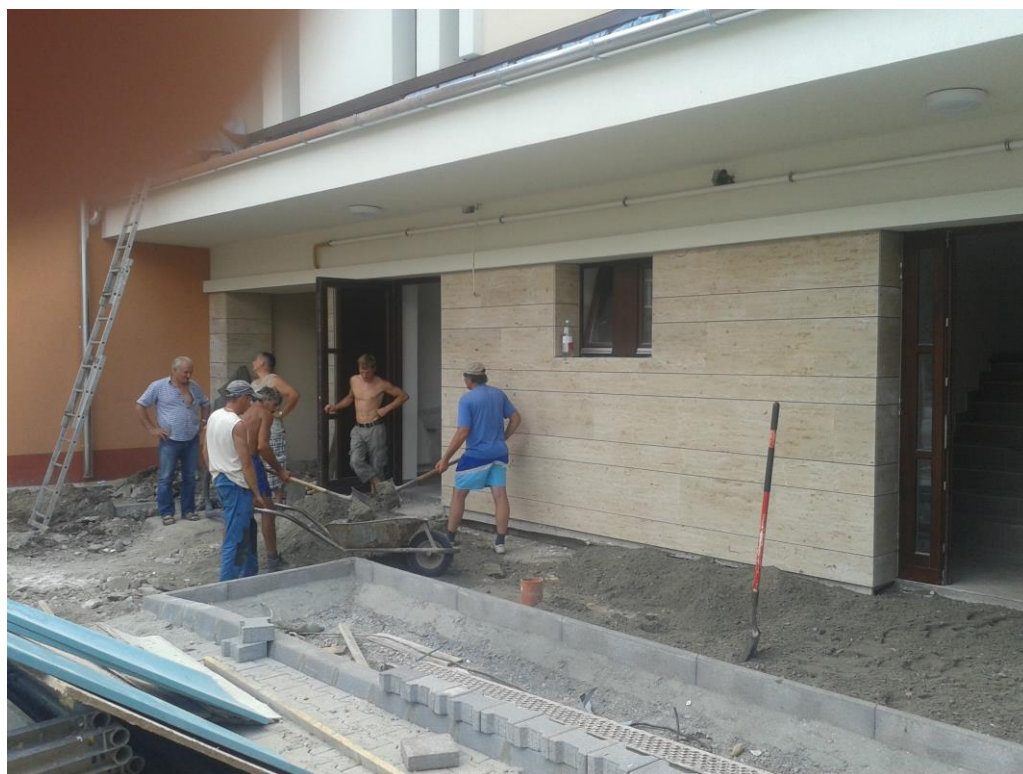
(főépület burkolás utáni udvari homlokzat)
