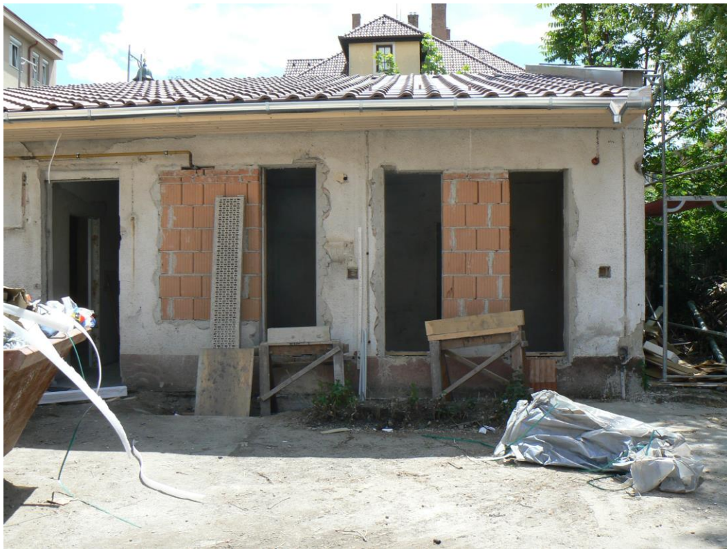
(hátsó melléképület burkolás előtti falszerkezete)
