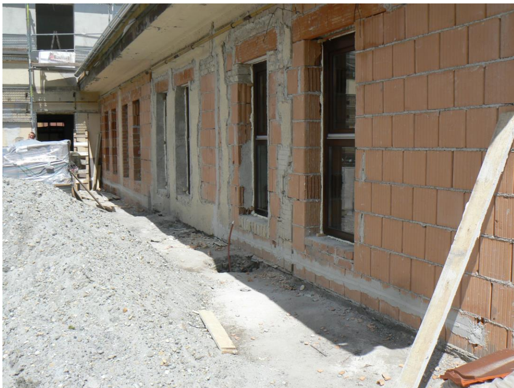
(burkolás előtti melléképület udvar felőli falszerkezete)
