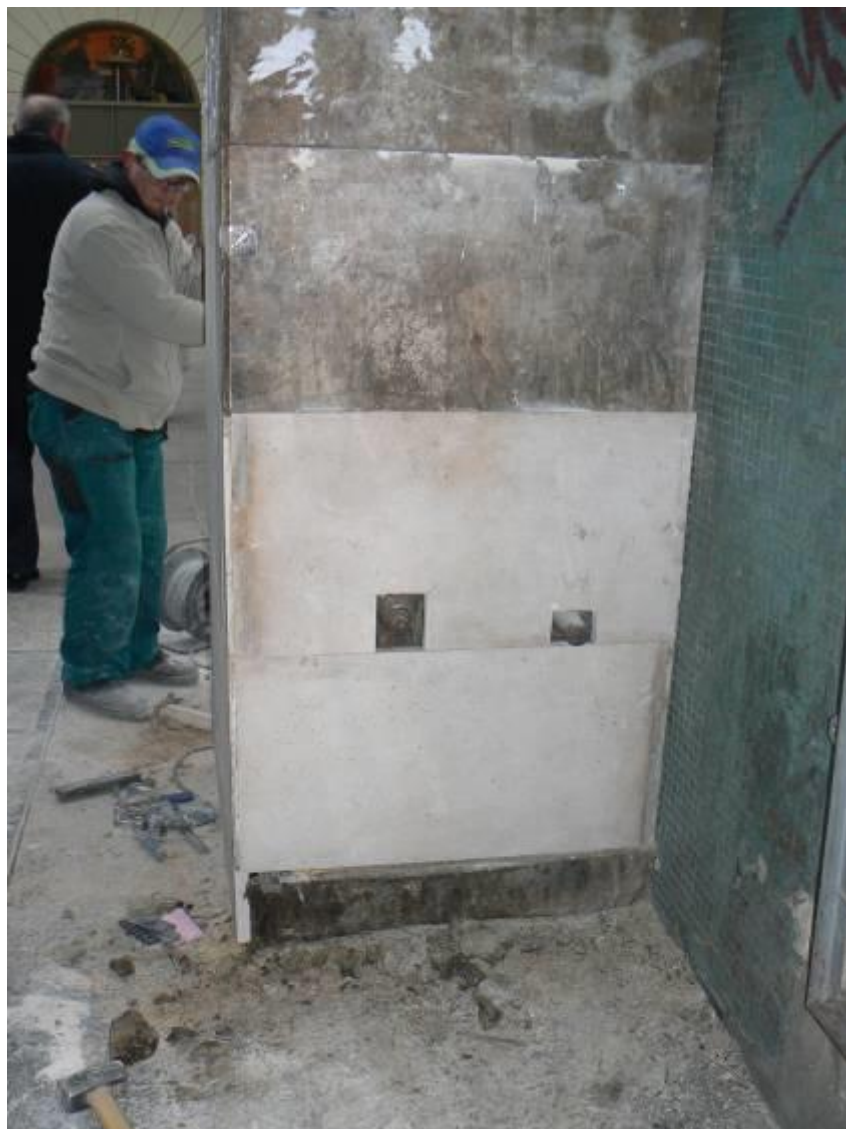
A régi falfelület alatti burkolat pótlása...
