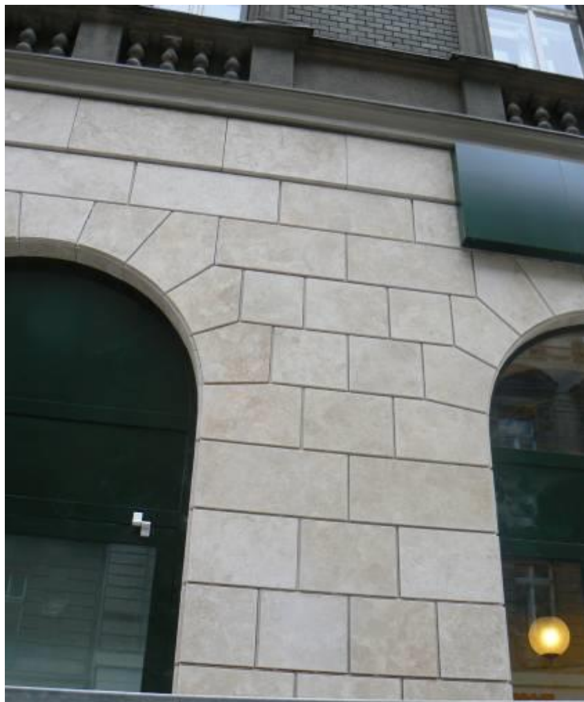
Homlokzati fal, a régé mészkő burkolati elemek bontása után, ... és új burkolattal...
