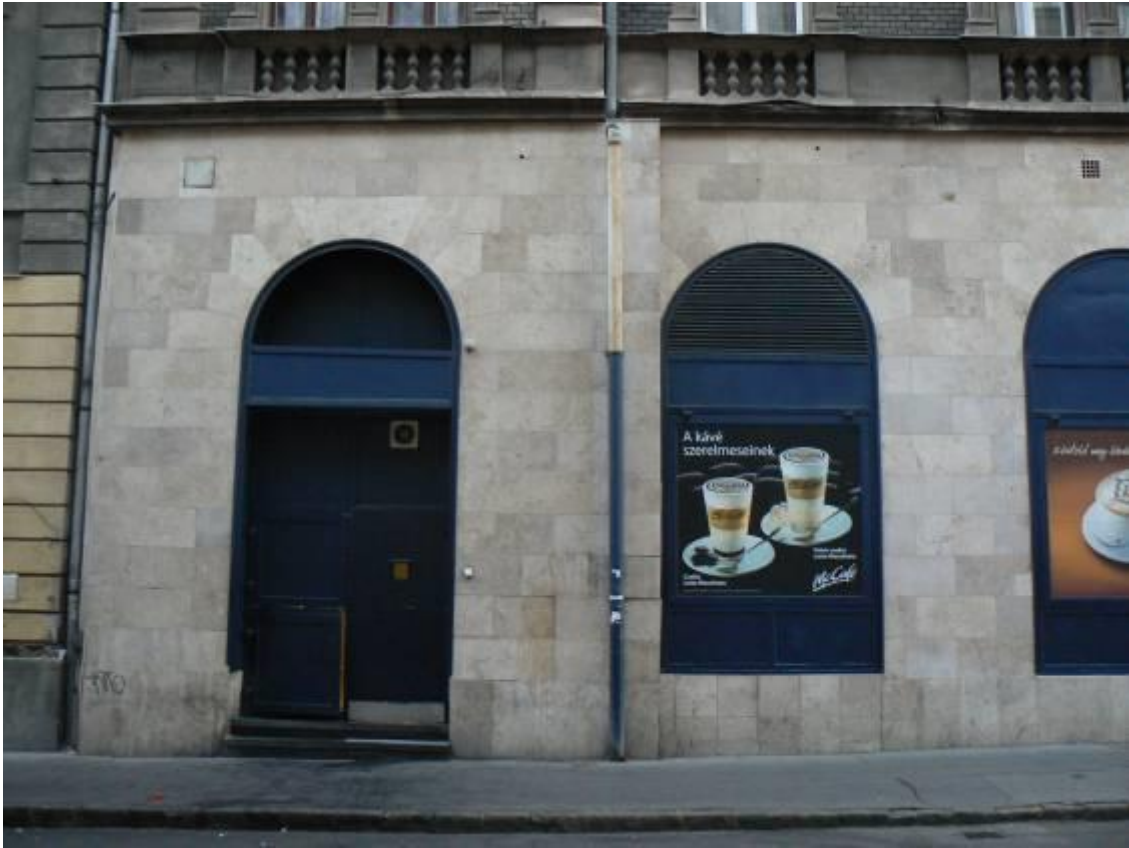
Gazdasági bejárat a meglévő burkolattal, alant pedig az újonnan készült burkolattal...
