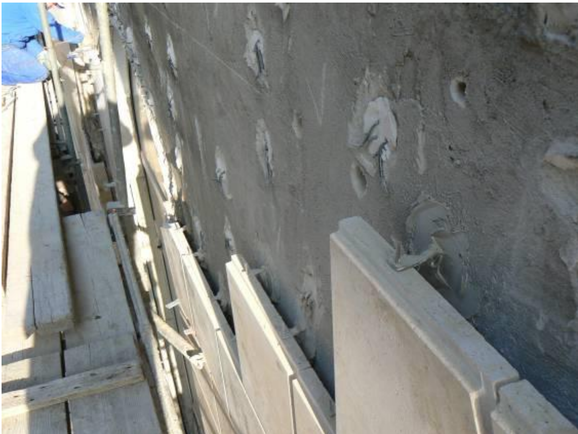
PROFIX Kft. rozsdamentes tartóelemeinek beépítése és rögzítése gyorskötő cementtel, ..
