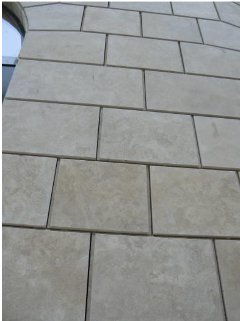
Nyílászárók közötti falfelület burkolata, ..
