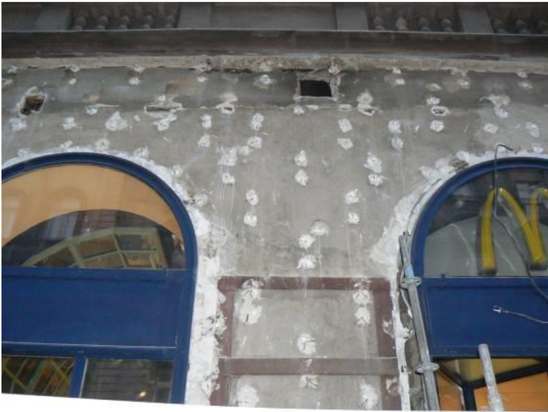
Homlokzati fal, a régé mészkő burkolati elemek bontása után, ... és új burkolattal...
