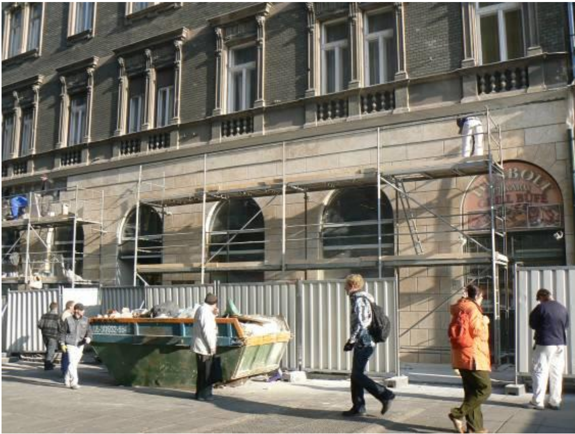
2011 november 16.-i állapot a homlokzati burkolási munkálatoknál..
