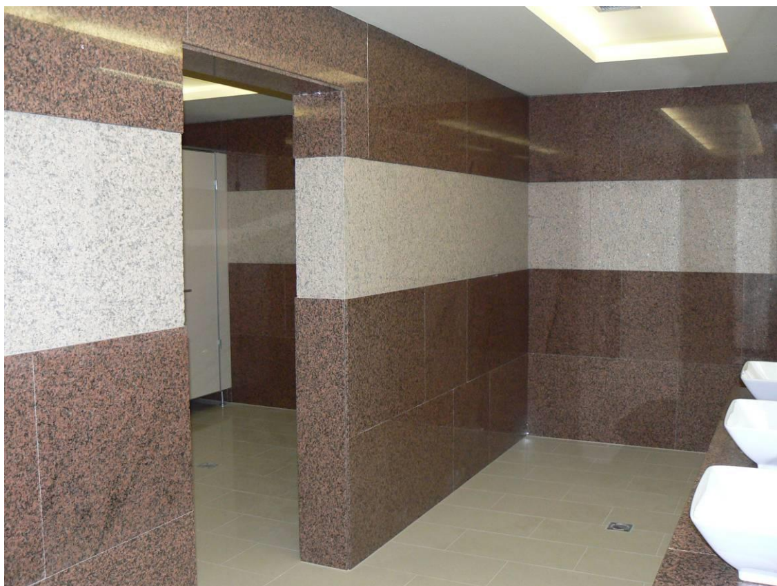
... és ugyanazon területen a vizesblokk felépítve, kőzetlap elemekkel burkolva
