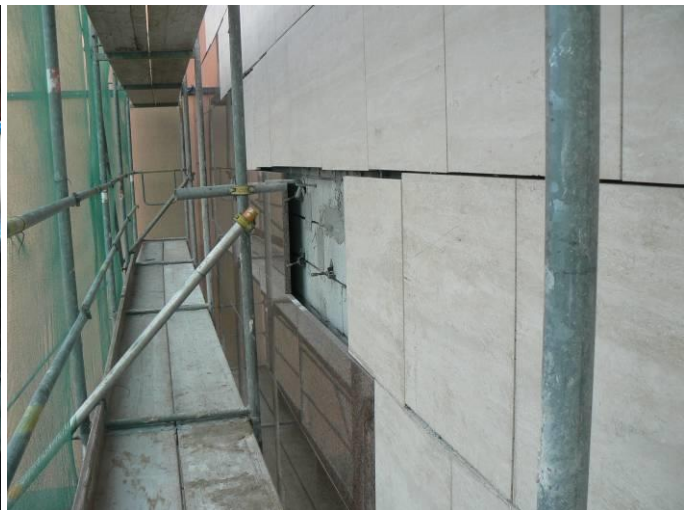
Kilazult homlokzati kőlapok (Déli homlokzat)
