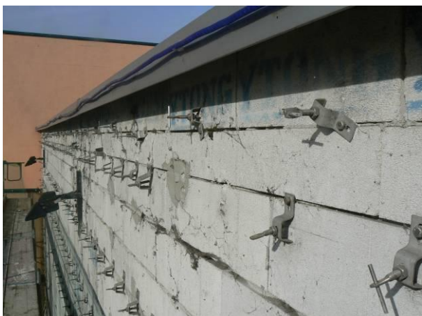
Falhézagba helyezett kőlap rögzítők
