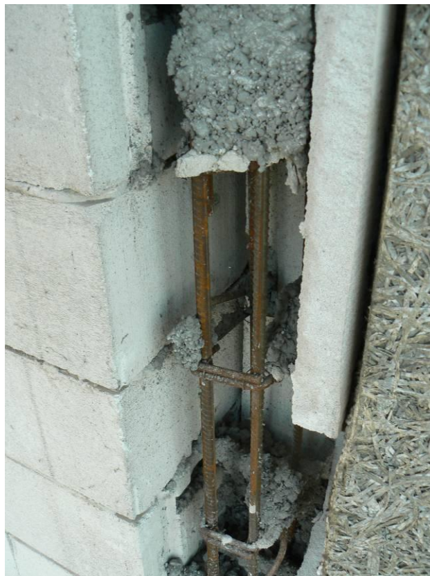
Közbülső merevítő pillér majdnem szakszerű betonozása
