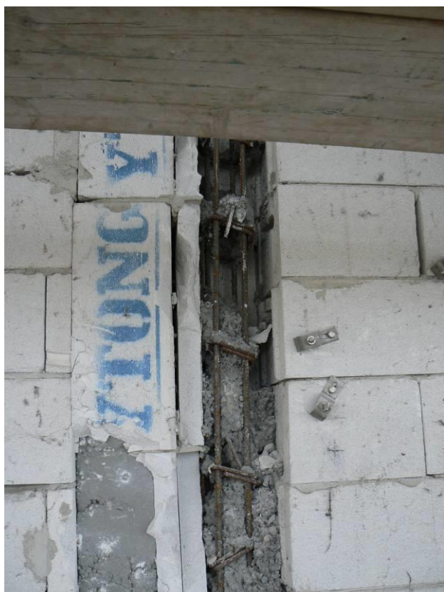
Ez már egy másik közbülső merevítő pillér, a kifejejtett betonnal
