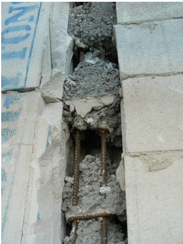
Közbülső merevítő pillér majdnem szakszerű betonozása
