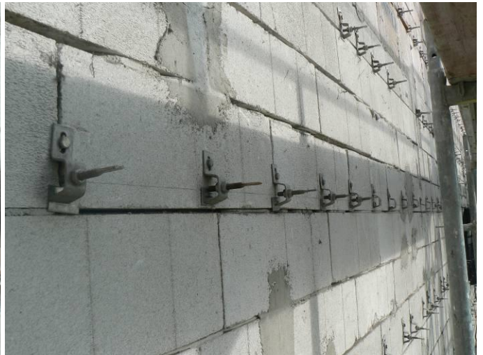
kőlap tartó konzolok téglafugázatba helyezve (bontás után)
