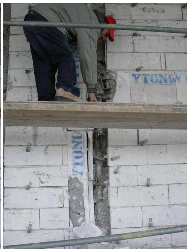
Ez már egy másik közbülső merevítő pillér, a kifejejtett betonnal
