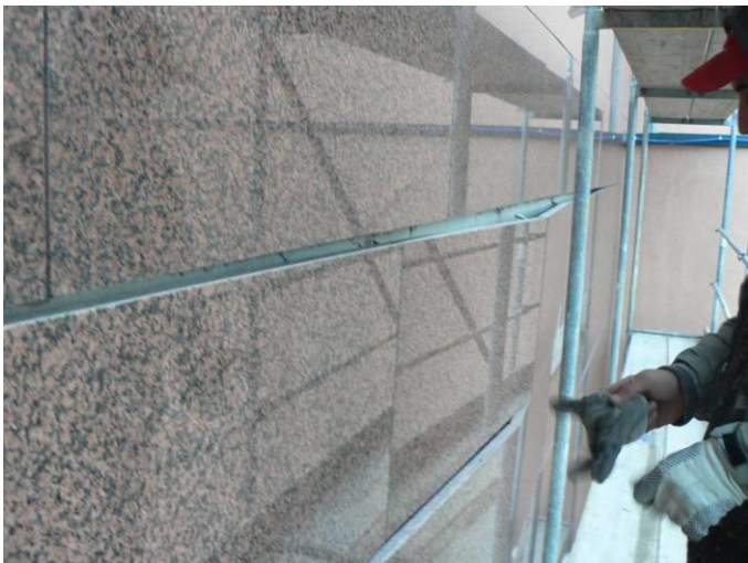
Kilazult homlokzati kőlapok (Déli homlokzat)
