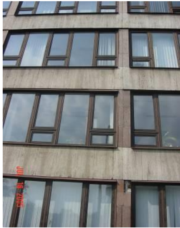
Kilazult kőlapok a homlokzaton
