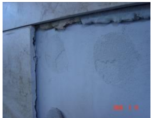
Biztos, hogy így kell falburkolatot helyezni ragasztásos technológiával? Ráadásul a szabványtól jelentősen eltérő nagyságú kőlapokat?
