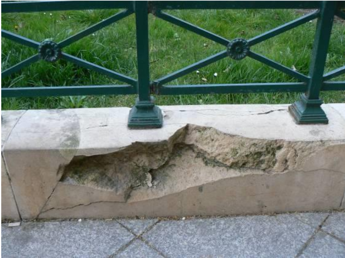
Fagyálló süttői édesvízi mészkő, alig 2 évvel a beépítése után ..
