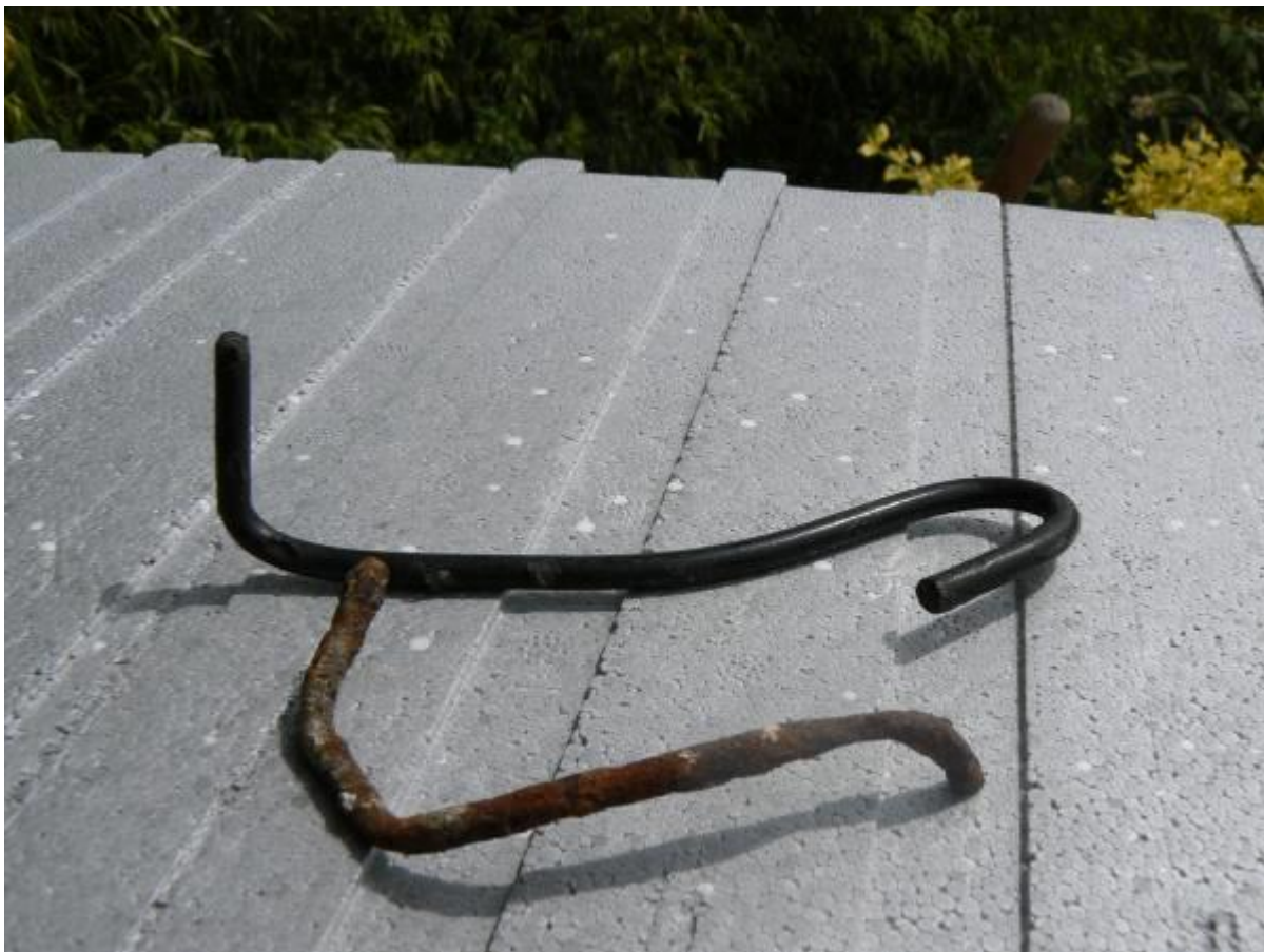
A gipsz érzékelhető hatása a szinterezett kapcsolódóra és betonacél kapcsolódóra (egyazon időpontban kivitelezett építmény homlokzatról kibontva!)
