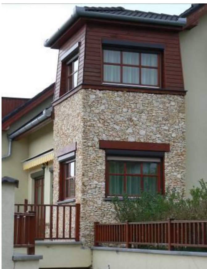
Mádi dolomit, szárazon rakott falburkolat
