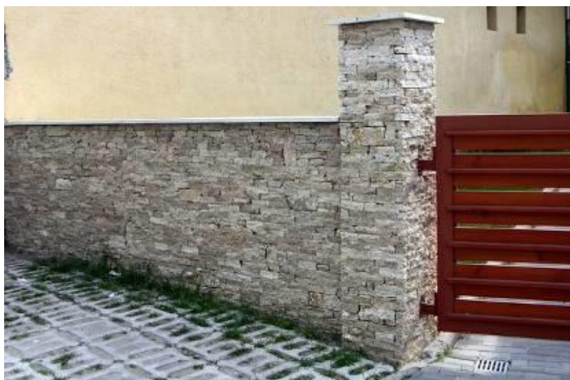
Mészkö ciklop, szakított felülettel, „szabálytalan” rakási móddal
