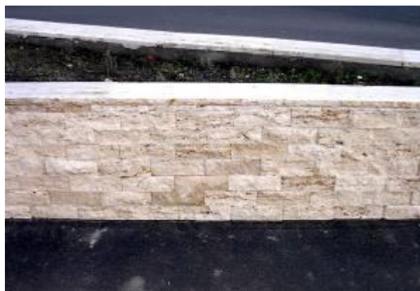
Süttői szakított felületű ciklop, zárt fugaképzéssel
