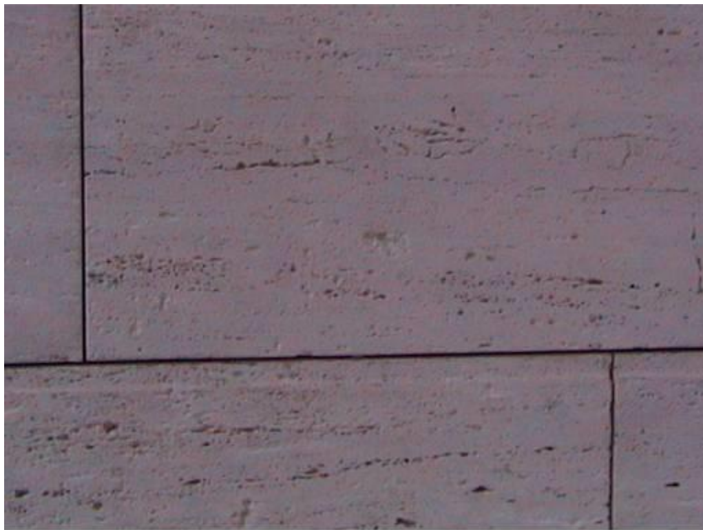
Debrecen, Kölcsey Központ homlokzati falburkolati homokszórt felületű köeleme
