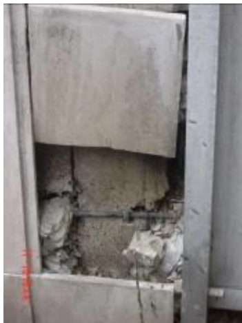
eltört kőlap és a mögötte található rögzítő szerkezet állapota
