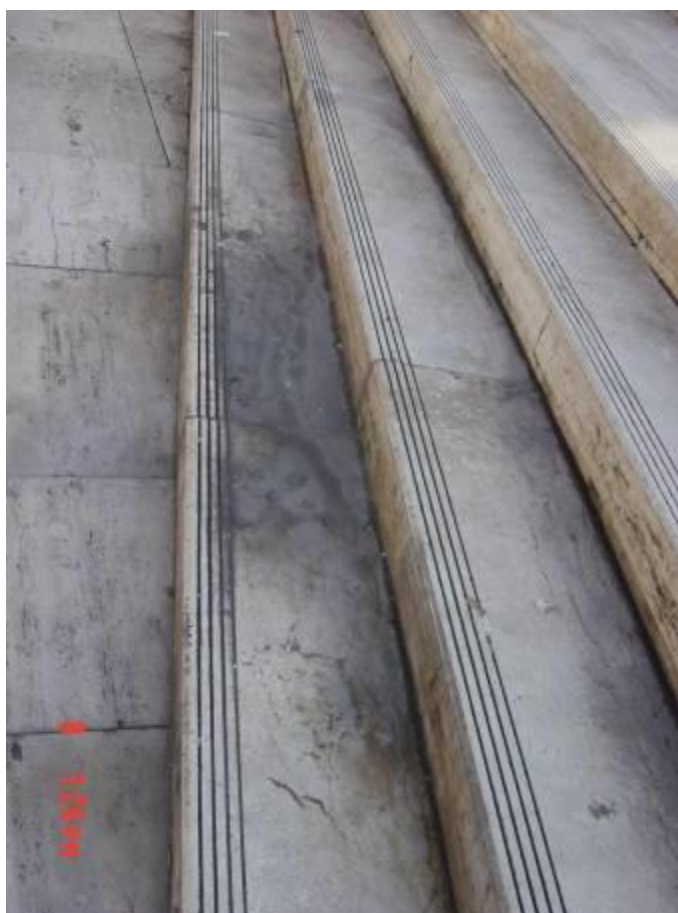
Erzsébet tér: befelé lejtő járólap
