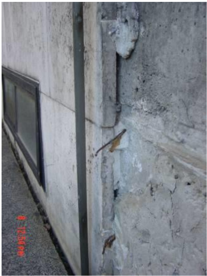
Lábazati kőburkolat és rögzítése acél kapoccsal
