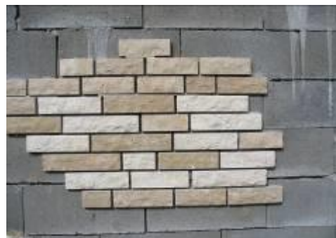
süttői „sprengelt” ciklop, nyitott hézaggal
