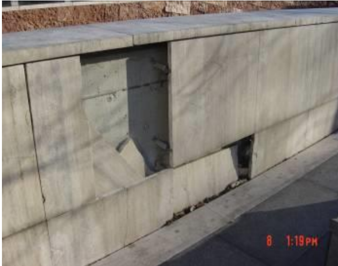
3 cm vtg. travertin falburkolat
