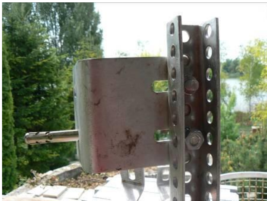
Függönyfal tartószerkezeti csomópont
