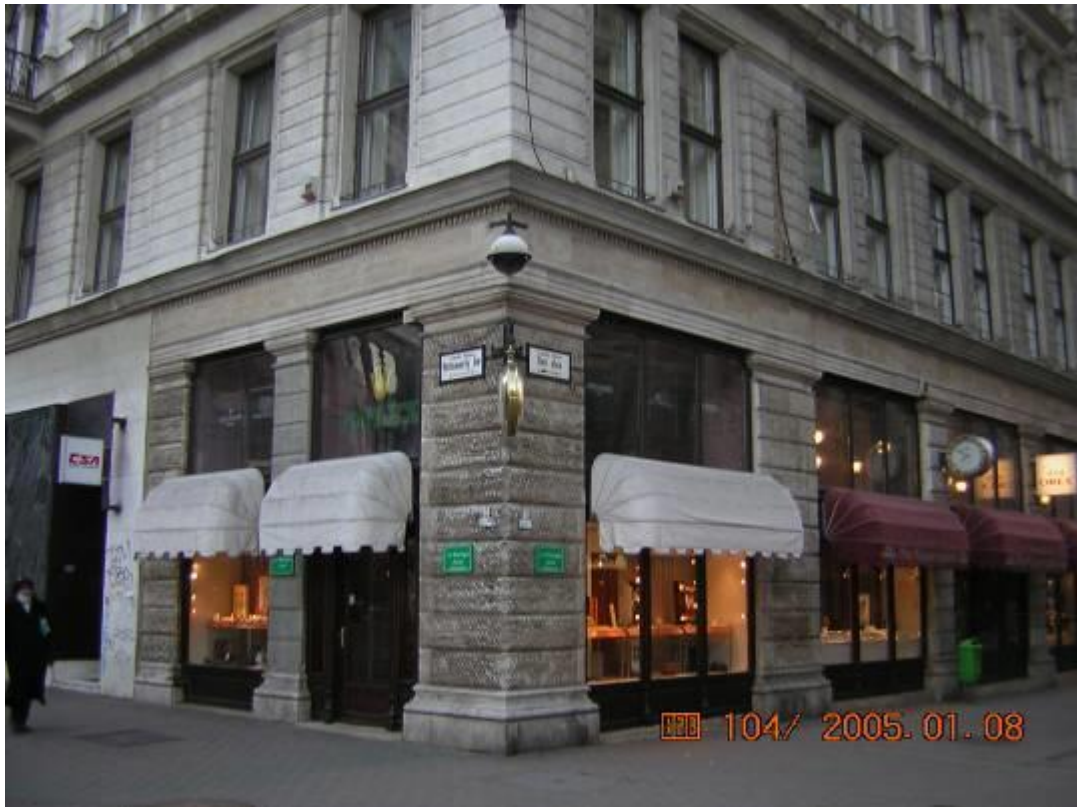
Cartier Óra és Ékszer szalon , teljes homlokzati kőburkolat csere az első osztó párkánnyal Kivitelezte: Opus-Stone Kőfaragó vállalkozás
