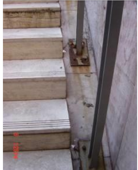
korlátok rögzítése majdnem rozsdamentes rögzítő szerkezetekkel
