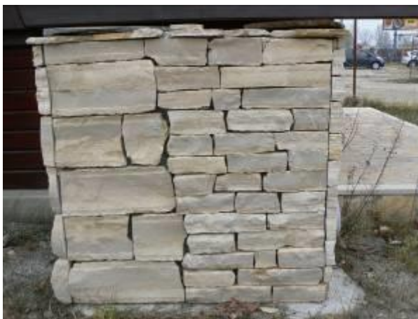
Horvát „szárazon rakott” mészkő falburkolat
