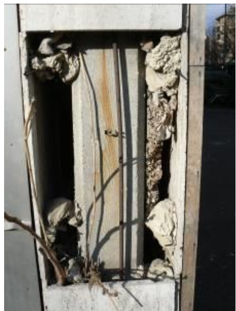
eltört kőlap és a mögötte található rögzítő szerkezet állapota
