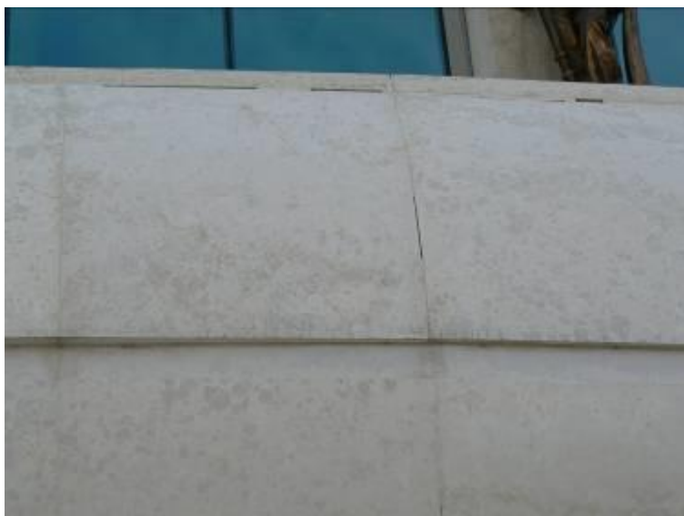
Nemzeti Színház fal- és fedkő burkolat kapcsolata, a fugázat, kipergés, és a kőlap mögé kerül a nedvesség.... Leesik, nem esik? Vajon mikor esik?
