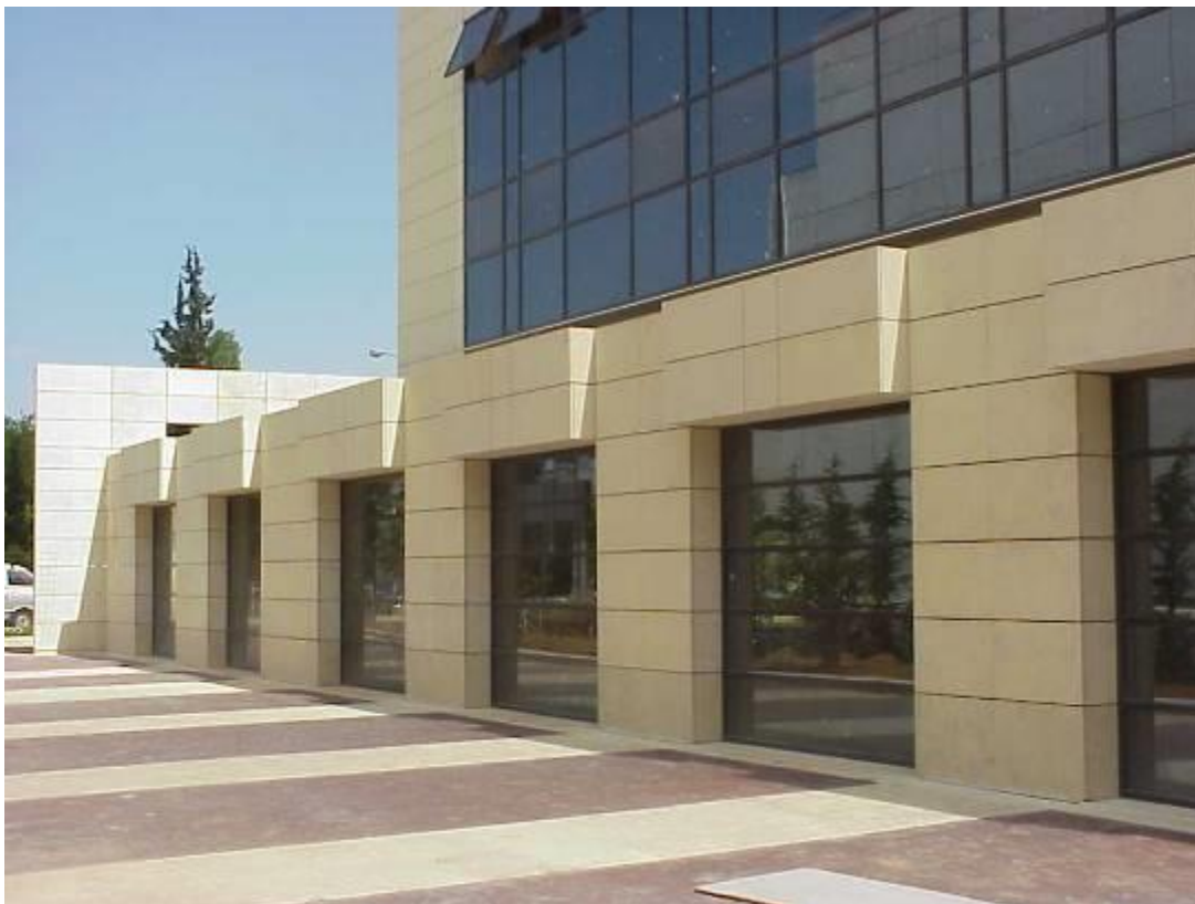
Irodaház, kőelemeket gyártotta: Lacomar Ltd.
