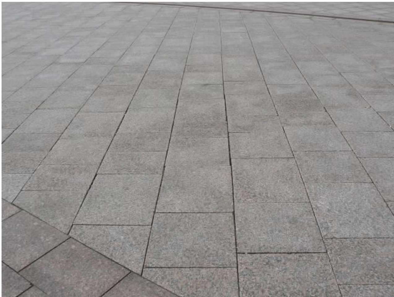
Budapest Sportsarnok (a kivitelező szerint vélhetően I. osztályú) térburkolat fugahézag képzése
