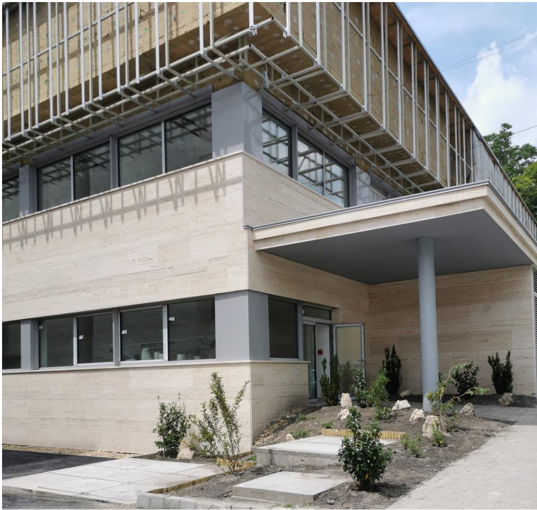
Onkológia Mellkassebészet homlokzati mészkő falburkolat (gyártási-kivitelezési terv és megvalósítás végzése)
