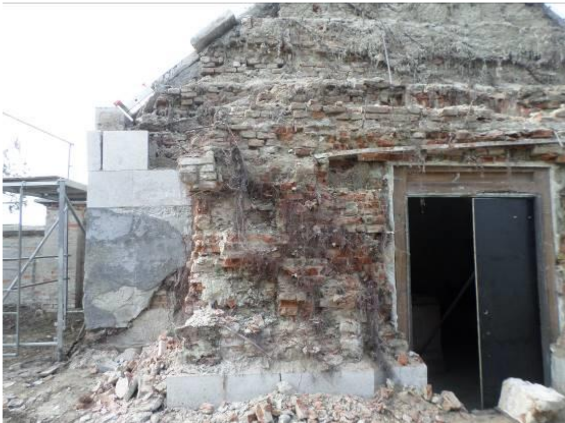
Kőelemek bontása után az elénk tároló teherhordó falszerkezet állapota
