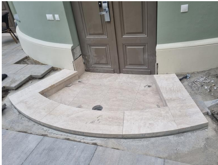
Szeged, Oroszlán utca „íves lépcső tervezése, gyártása, kivitelezése
