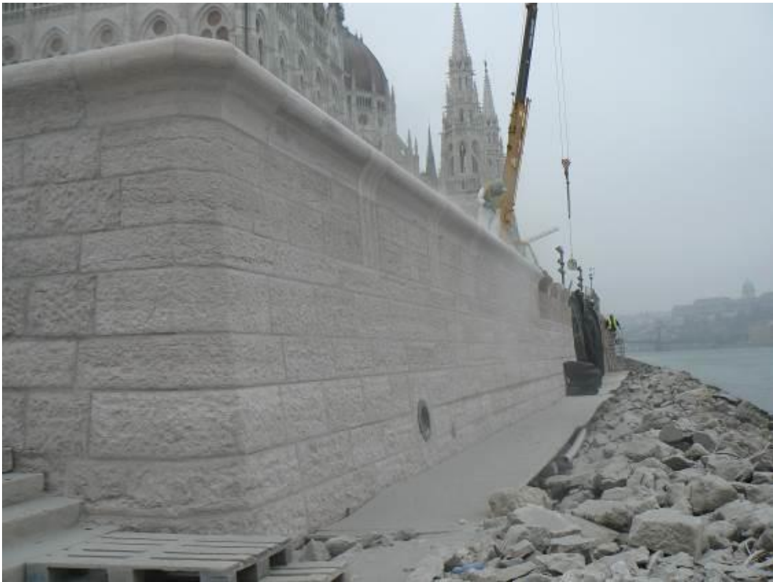
Duna-parti támfal szerkezet burkolása Tardosi vörös mészkővel (gyártási-kivitelezési terv és megvalósítás végzése)
