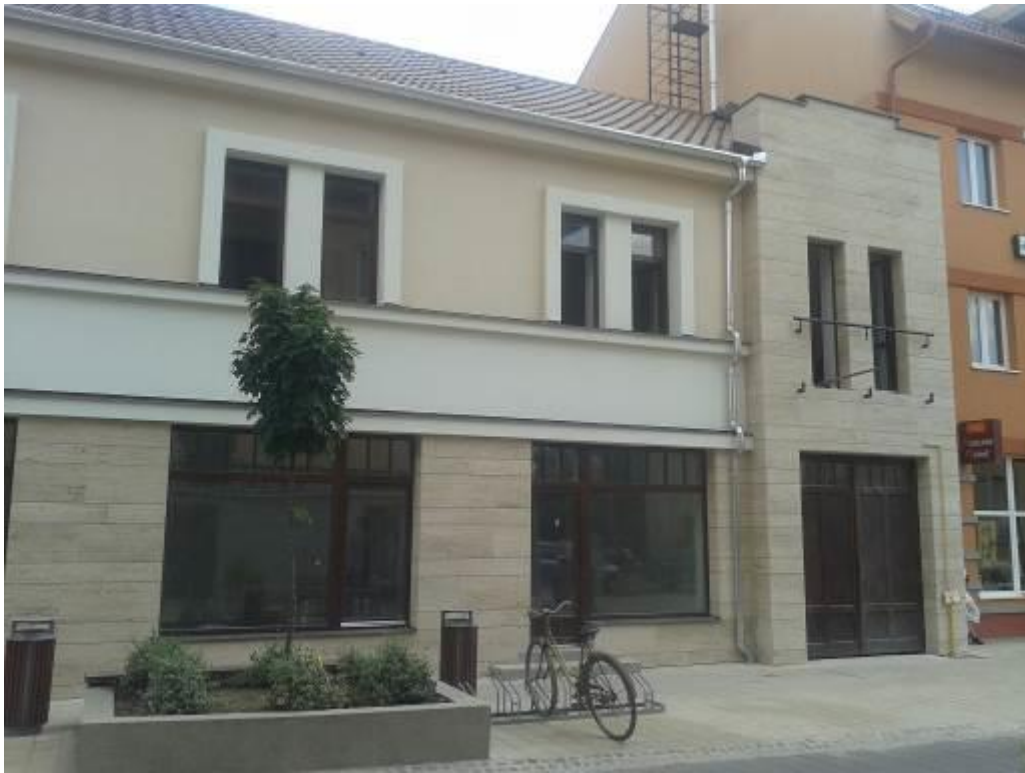
Monor, Posta épület homlokzat, Jura mészkő, ragasztott technológiával (gyártási-kivitelezési terv és megvalósítás végzése)
