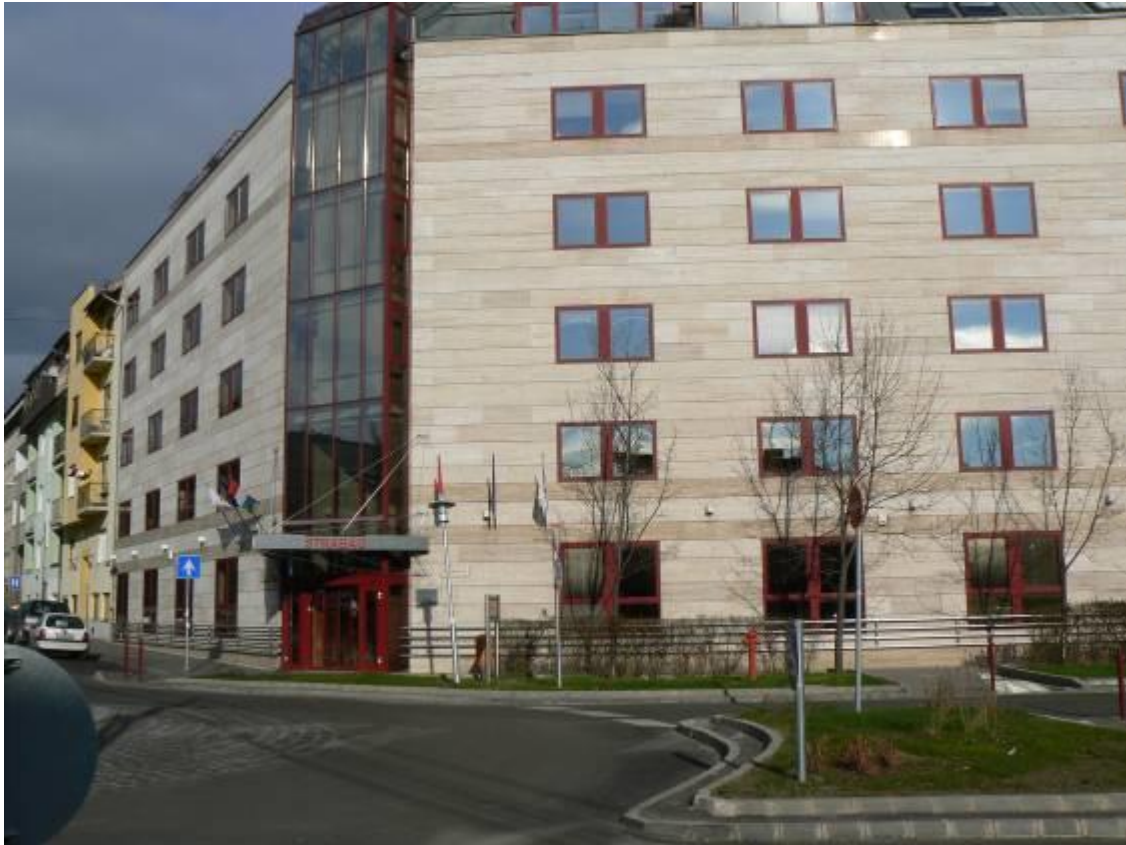
STRABAG Irodaház, süttői mészkő homlokzat burkolat (gyártási-kivitelezési terv és megvalósítás végzése)
