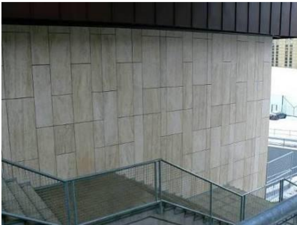
Budapest, XI. ker. SPORTCENTRUM homlokzat (gyártási-kivitelezési terv és megvalósítás végzése)
