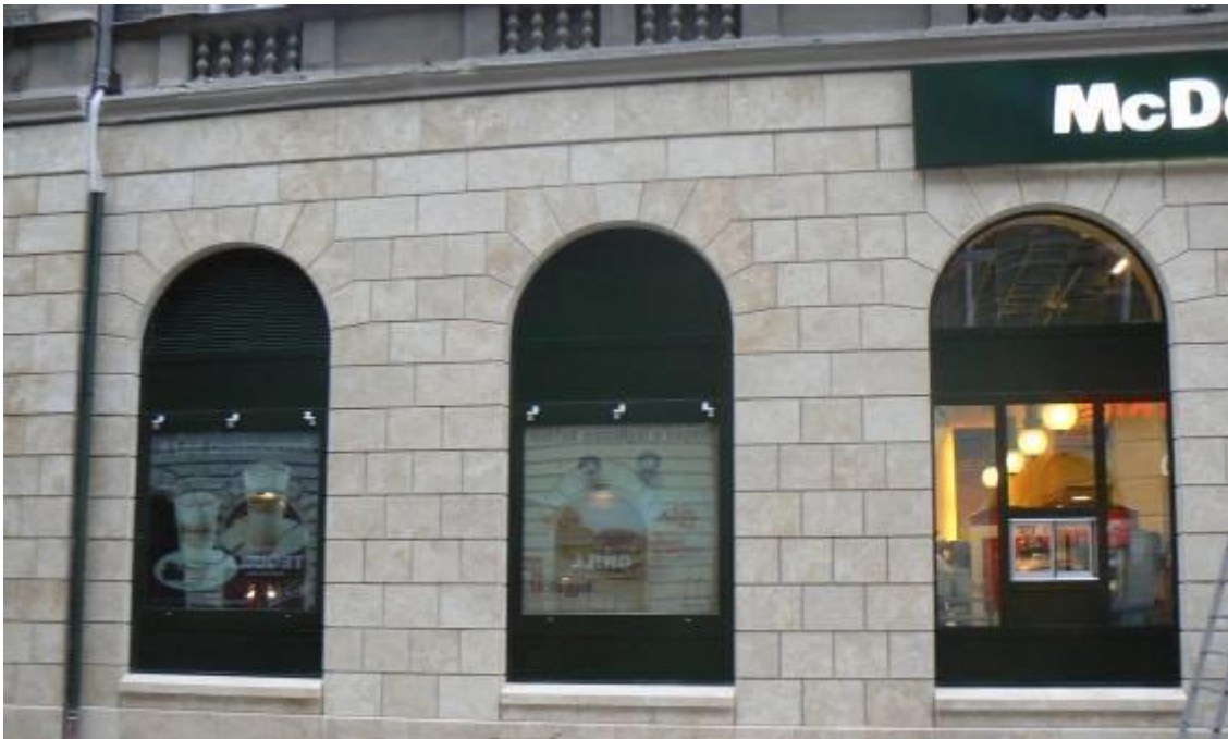
Budapest, Baross tér McDonald's (gyártási-kivitelezési terv és megvalósítás végzése)
