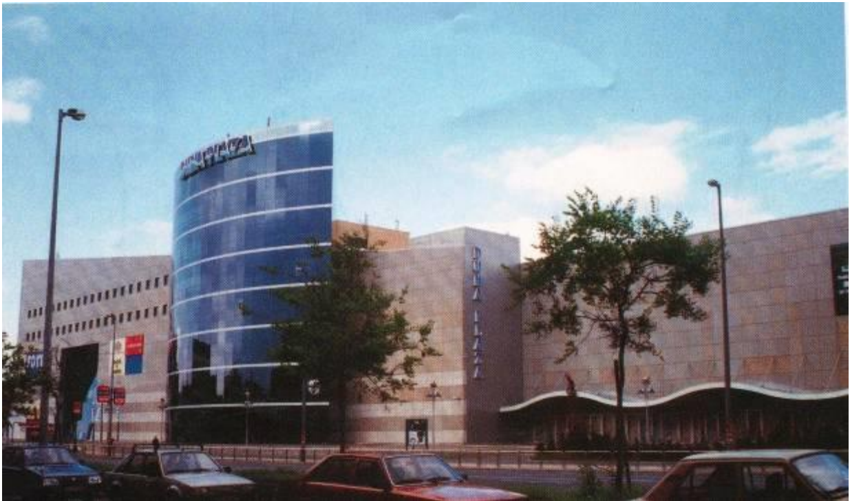
DUNAPLATZA, (gyártási-kivitelezési terv és megvalósítás végzése)
