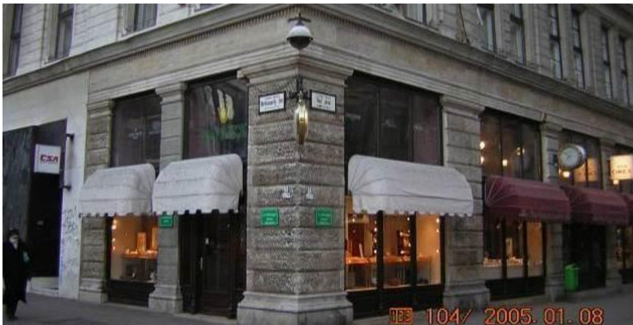
Budapest, V. ker. Cartier Óra- és Ékszer Szalon (teljes homlokzati kőburkolat tervezése majd új köelemek beépítésével megvalósítása, bontás és csere, kőzetfelület antikulása)
